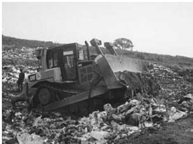
写真-2 埋立処分場での作業
